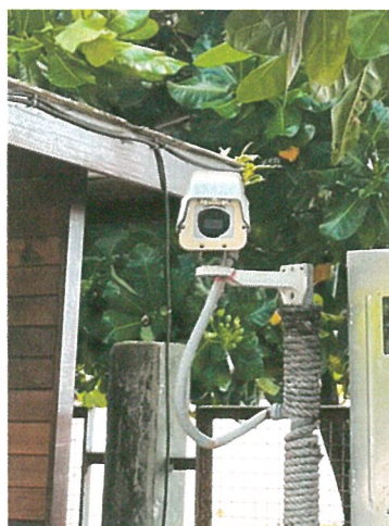
รูปภาพที่ 2.38 ระบบโทรทัศน์วงจรปิด (CCTV)
