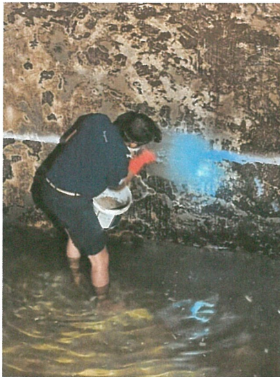
รูปภาพที่ 2.16 การล้างทำความสะอาดถังเก็บน้ำใช้
