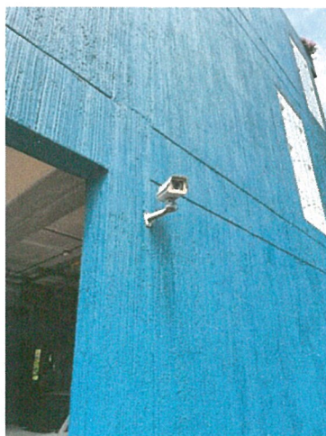
รูปภาพที่ 2.38 ระบบโทรทัศน์วงจรปิด (CCTV)
