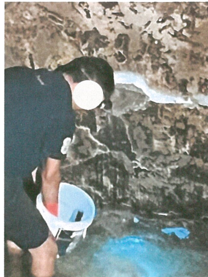
รูปภาพที่ 2.16 การล้างทำความสะอาดถังเก็บน้ำใช้
